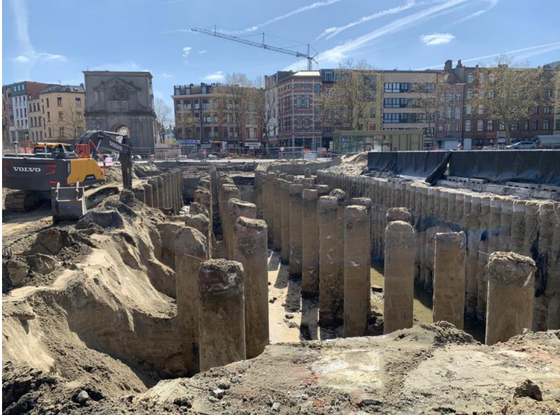
Collectieve hemelwaterput op het plein van de Gedempte Zuiderdokken – in aanbouw
